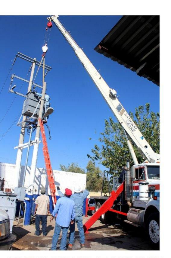
El H. Ayuntamiento de Agua Prieta a través de OOMAPAS, realiza cambio y colocación de transformador nuevo, para pozo de agua #2 ubicado en calle 2 avenida 14.
